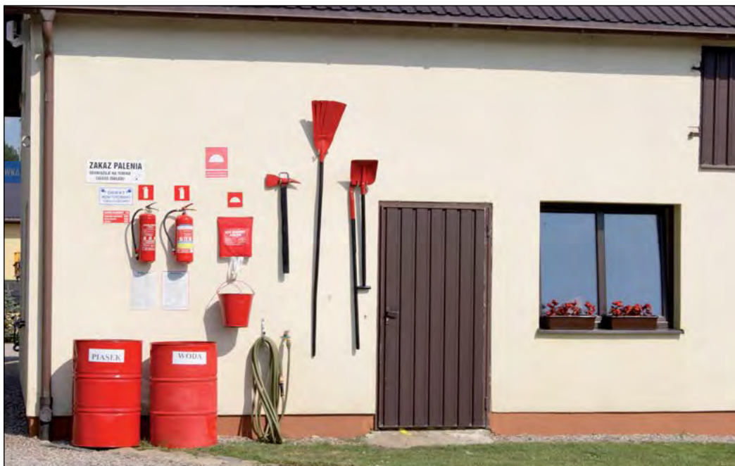
Fot. 20. W każdym gospodarstwie rolnym powinien znajdować się łatwo dostępny zewnętrzny punkt przeciwpożarowy wyposażony w: drabinę, bosak, siekierę, łopaty, tłumice, wiadra, gaśnice, pojemniki z wodą i z piaskiem. Sprzęt ten należy trzymać pod zadaszeniem, a piasek i wodę należy chronić przed zanieczyszczeniem i zamrożeniem.
